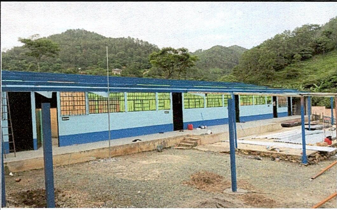
Foto 1: Vista panorámica del techo a sustituir.
