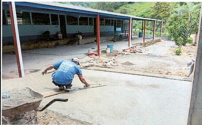
Foto 3: Cubierta delantera, parte externa.
