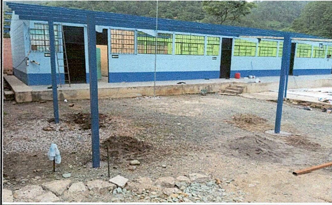
Foto 1: Vista panorámica del techo a sustituir.
