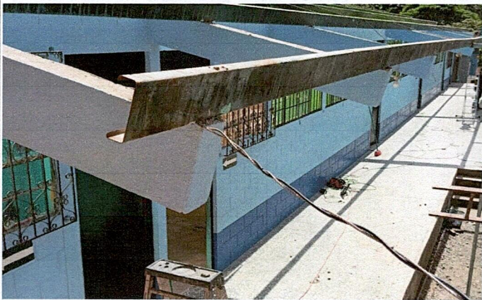
Foto 3: Cubierta delantera, parte externa.
